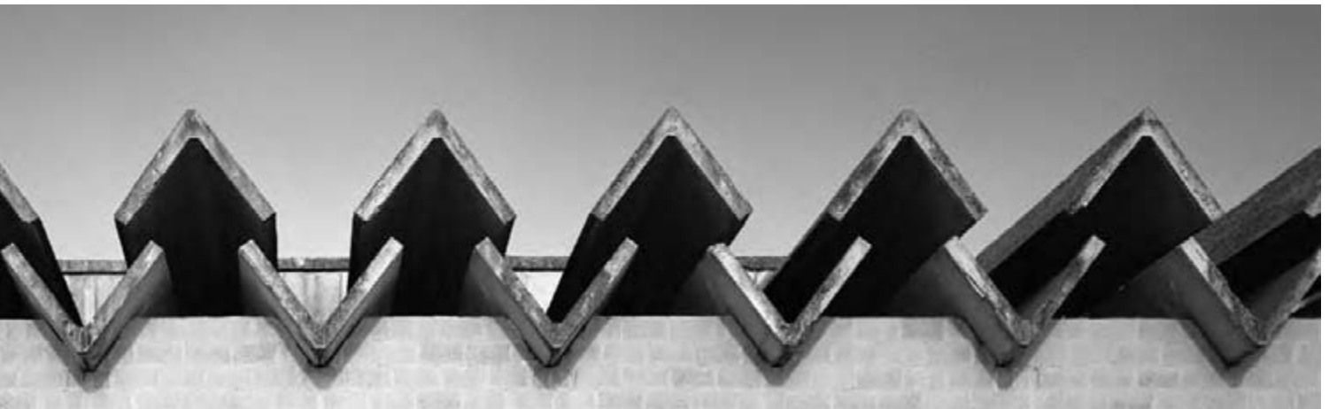
foto Mario Ferrara, 2009 SPARANISE (CASERTA). STABILIMENTO POZZI E GINORI. PARTICOLARE
