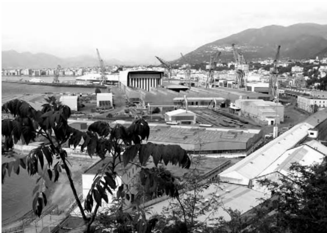
5. Castellammare di Stabia (Napoli). I cantieri e la corderia allo stato attuale (foto Ornella Cirillo).
