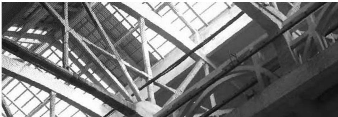
6. Cantieri del Muggiano, La Spezia, ex officina navale, particolare della struttura di copertura oggi.
