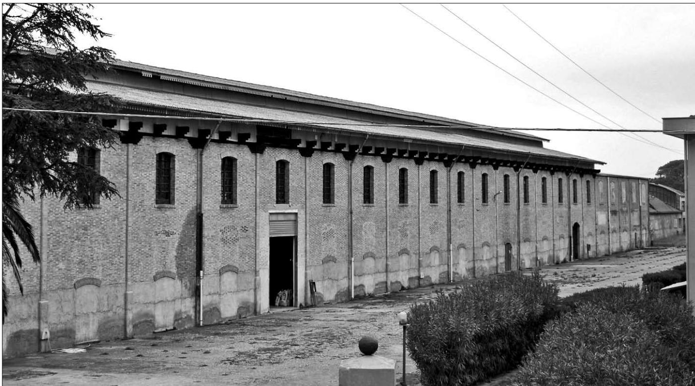
7 Stabilimento SAIM "Farinia"- Pontecagnano (Salerno), vista laterale del tabacchificio. Il complesso presenta una struttura di pilastri di cemento visibili in prospetto, con tamponamenti di mattoni e copertura in legno (foto Antonella Marciano, 2012).
